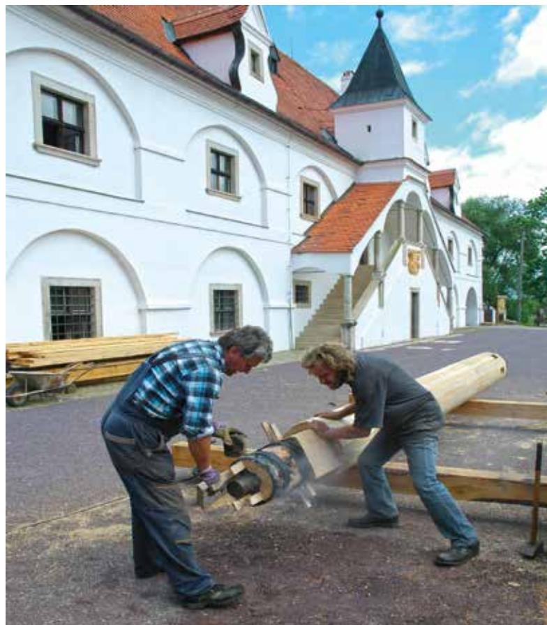
Slup, Technické muzeum v Brně, vodní mlýn. Fotodokumentace výměny hřídele jednoho z vodních kol. Foto Ondřej Merta, 2012.
