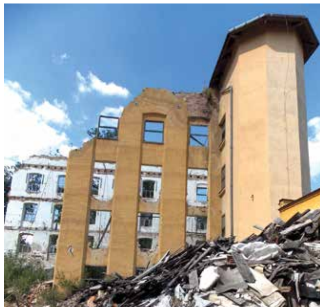
Svitávka, ruiny bývalé textilní továrny. Průmyslový objekt nenašel nové využití a postupně se rozpadá. Foto Ondřej Merta, 2015.
