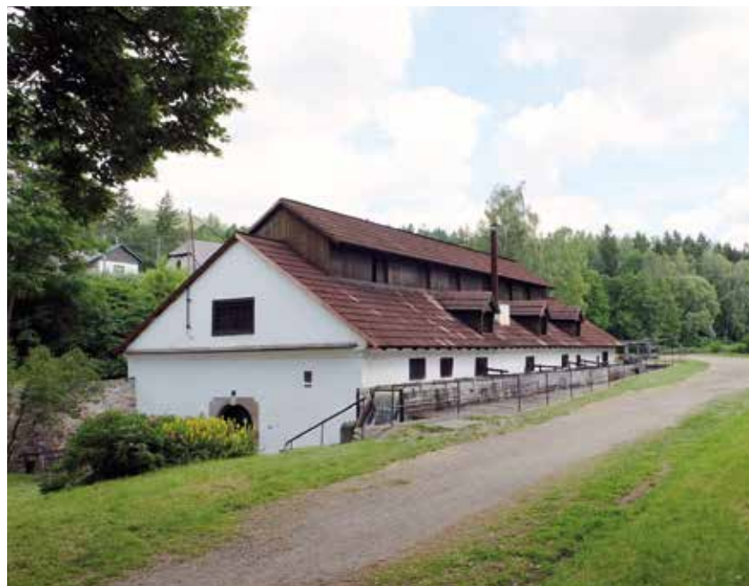
Dobřív, Západočeské muzeum v Plzni, vodní hamr. Národní kulturní památka Hamr v Dobřívě s kompletně vybaveným strojním vybavením ve funkčním stavu umožňujícím prezentaci technologie. Foto Ondřej Merta, 2016.
