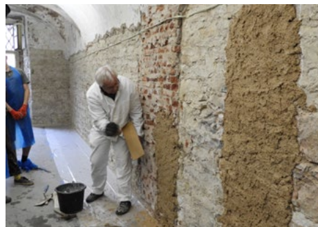
↑ Kurz práce s vápnem v Invalidovně v Praze. Postup nahazování odsolovací omítky předvádí profesor Václav Girsy
