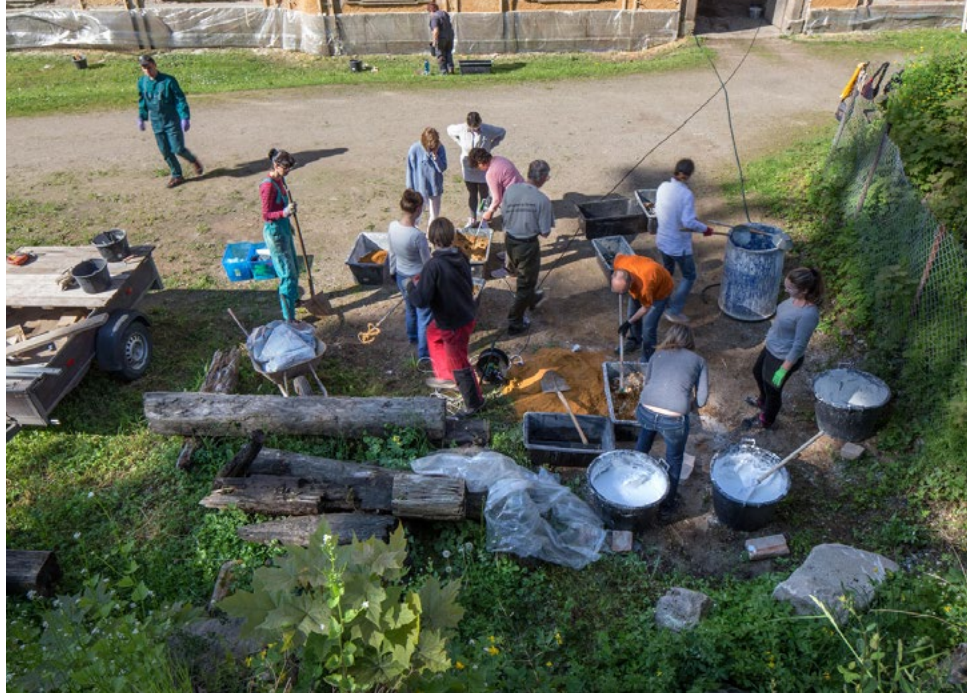
↑ Příprava staveništní vápenné malty v rámci letní školy
